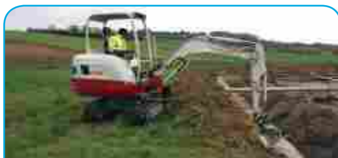
Février : travaux à la station d'épuration pour renouveler la bâche géotextile
